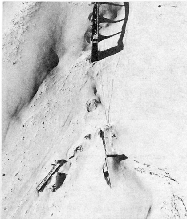
Bild 1 Luftaufnahme des am 2.2.78 durch eine Lawine zerstörten Hegernviaduktes der Niesenbahn
