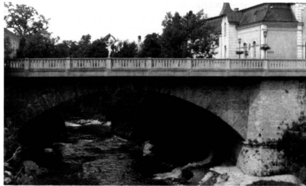
Bild 3 Brücke über der Grossen Erlauf in Purgstall, 1988
