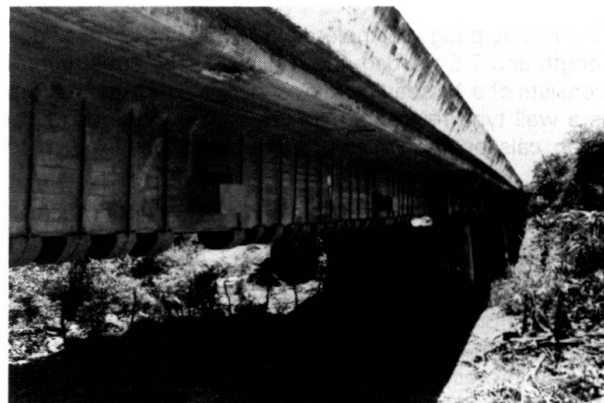
Vue générale après travaux de renforcement. Précontrainte verticale par étriers tendus.
