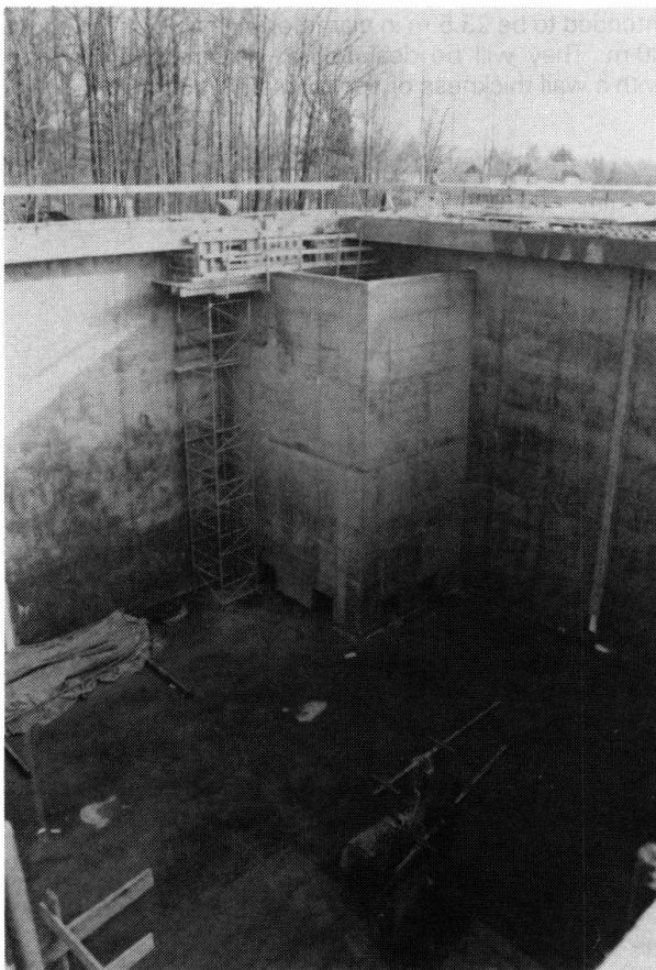
Bild 1 Blick in das Behälterinnere und auf die Spannwagen
