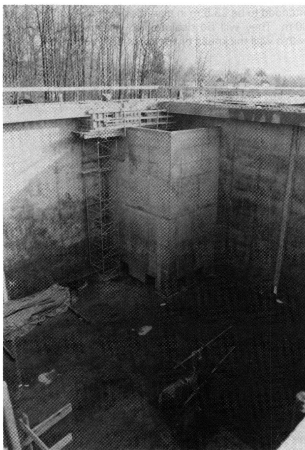
Bild 1 Blick in das Behälterinnere und auf die Spannweiten
