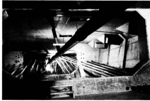
Fig. 24 - Viaduc de Poncin - Précontrainte extérieure
