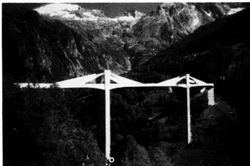
Fig. 36 - Pont du Ganter
