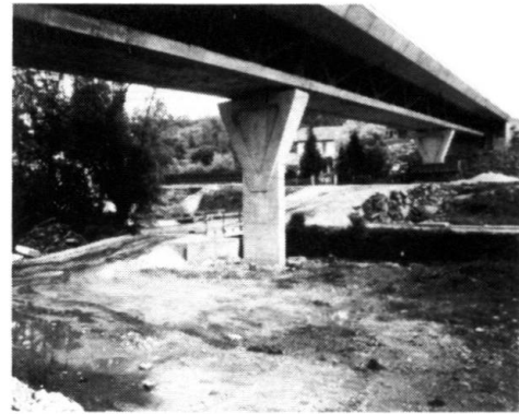
Fig. 11 - Pont d'Arbois - Vue de l'ouvrage
