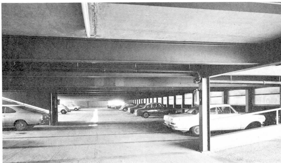
Bild 3: Innenansicht mit Blick in ein Parkhausschiff.
