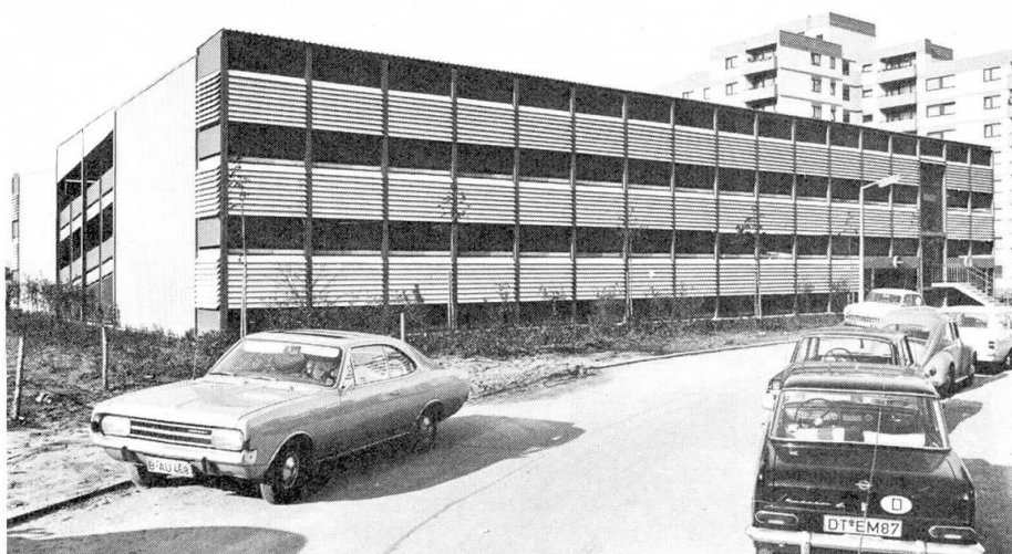
Bild 2: Außenansicht eines Parkhauses in Berlin-Rudow. Verkleidung der Fassade mit Asbestzementtafeln.
