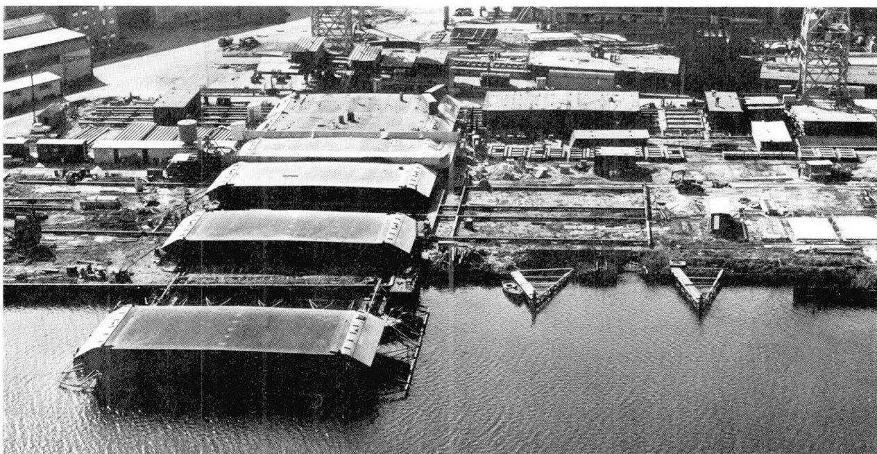
Fig. 4. Sektionsfertigung. Im Hintergrund: Zusammenbau und Kontrolle; Mitte: Malerstation (vor Errichtung der Anstrichhalle); im Vordergrund Verschiffung.
