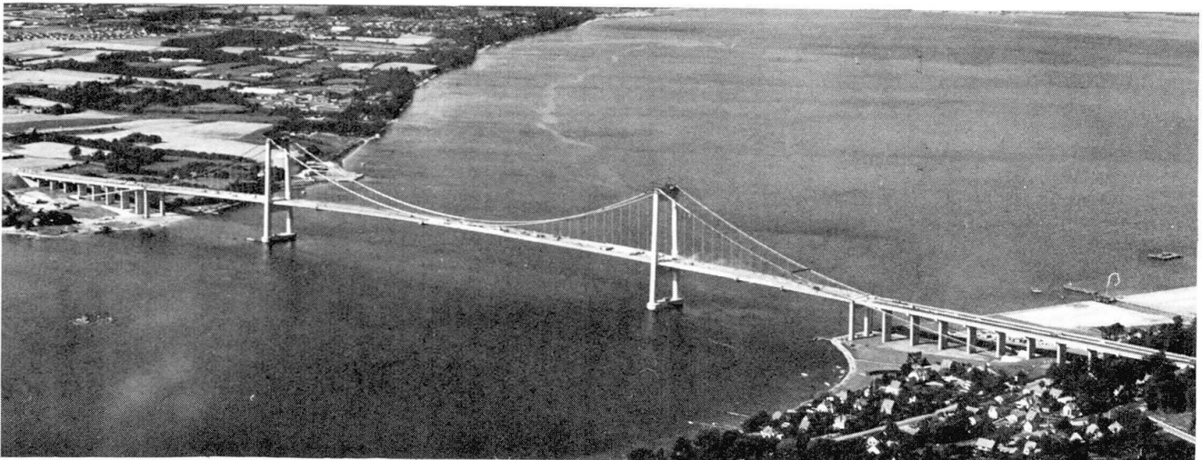
Fig. 1. Ansicht der fertigen Brücke.
