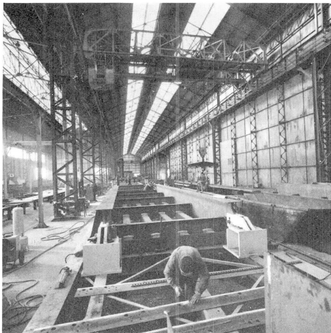
Photo 4. - Assemblage des pièces de pont et des poutres principales
