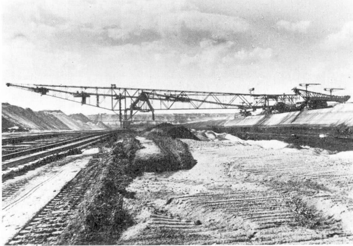
Bild 2: 60 m Abraumförderbrücke
