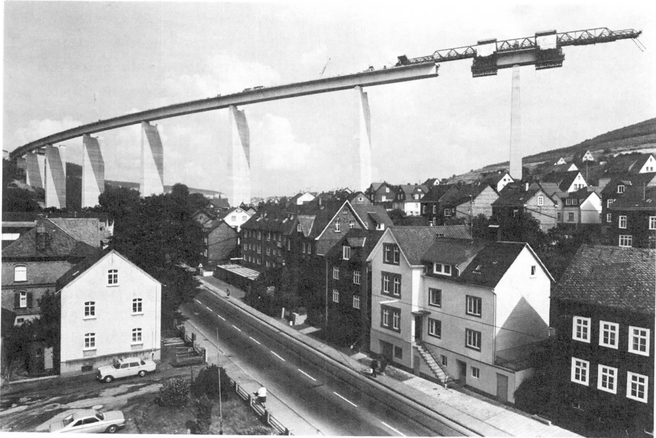
Fig. 11 Siegtalbrücke Eiserfeld - Bauzustand mit Vorschubrüstung
