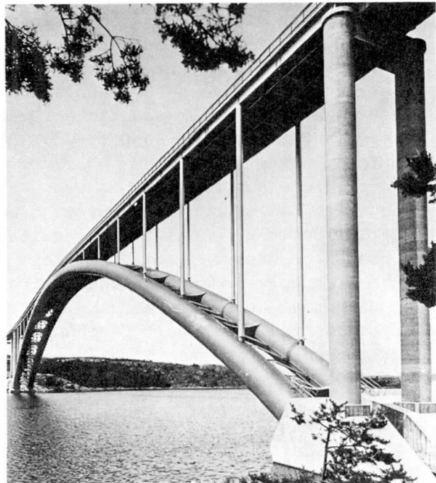
Tjörnbrücke in Schweden (1960)
