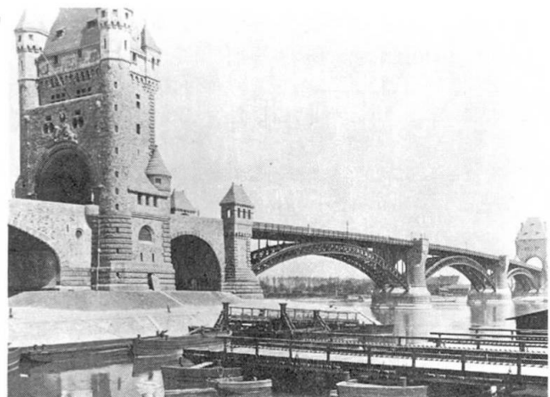
Nibelungenbrücke bei Worms (1897)
