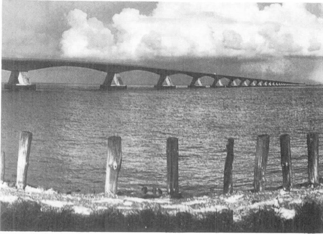
Bild 13: Brücke über die Oosterschelde (Holland)
