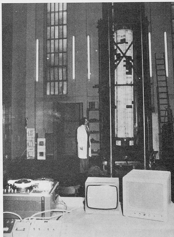
Fig. 8 Modèle d'une des colonnes sous la presse de 2.000 t
