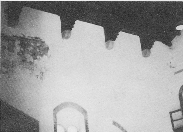
Fig. 5 Mur Nord dans le visible
