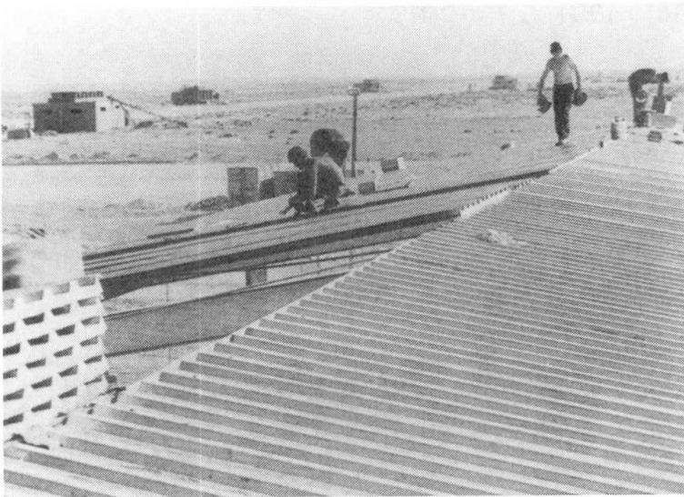
Abb.1: Montage von Sandwich-Dachbauteilen
