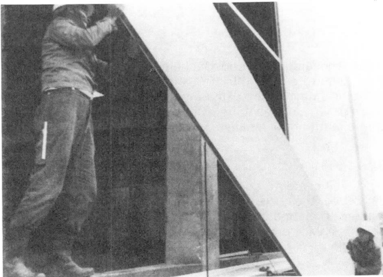
Abb.2: Montage von Sandwich-Wandbauteilen
