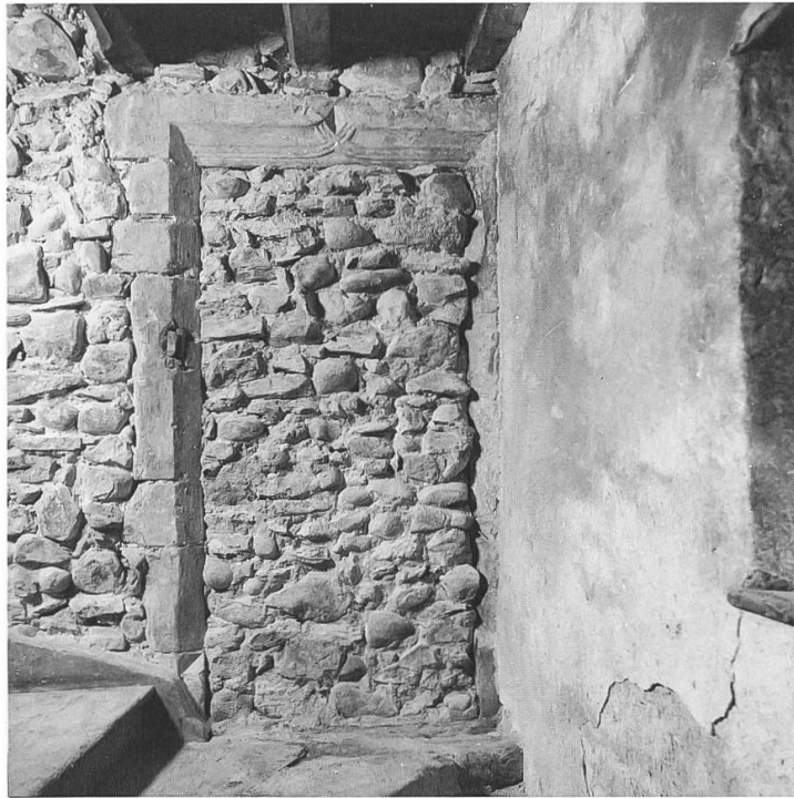
Fig. 45. Porte du XVI e siècle au premier étage de l'escalier à vis du n° 35 de la rue du Midi.
