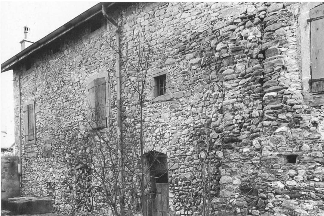
Fig. 46. Face occidentale du n° 35 de la rue du Midi, avec à droite les traces de la façade nord originale et à gauche l'agrandissement de 1342-43 remanié à plusieurs reprises dès le XVI e siècle.
