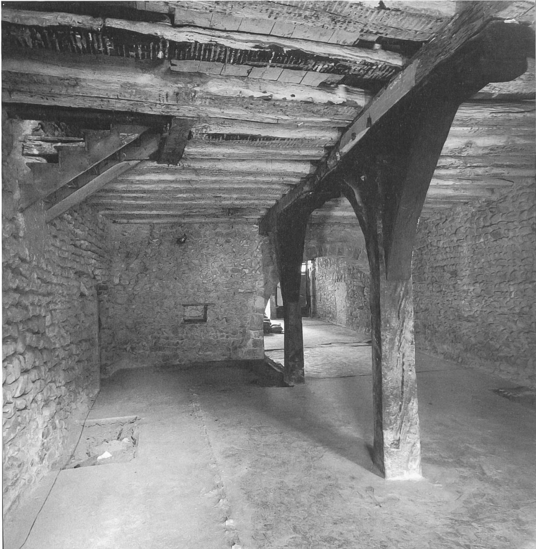
Fig. 16. Vue de la cave du n° 26 A de la rue du Nord avec les piliers de 1253 environ.
