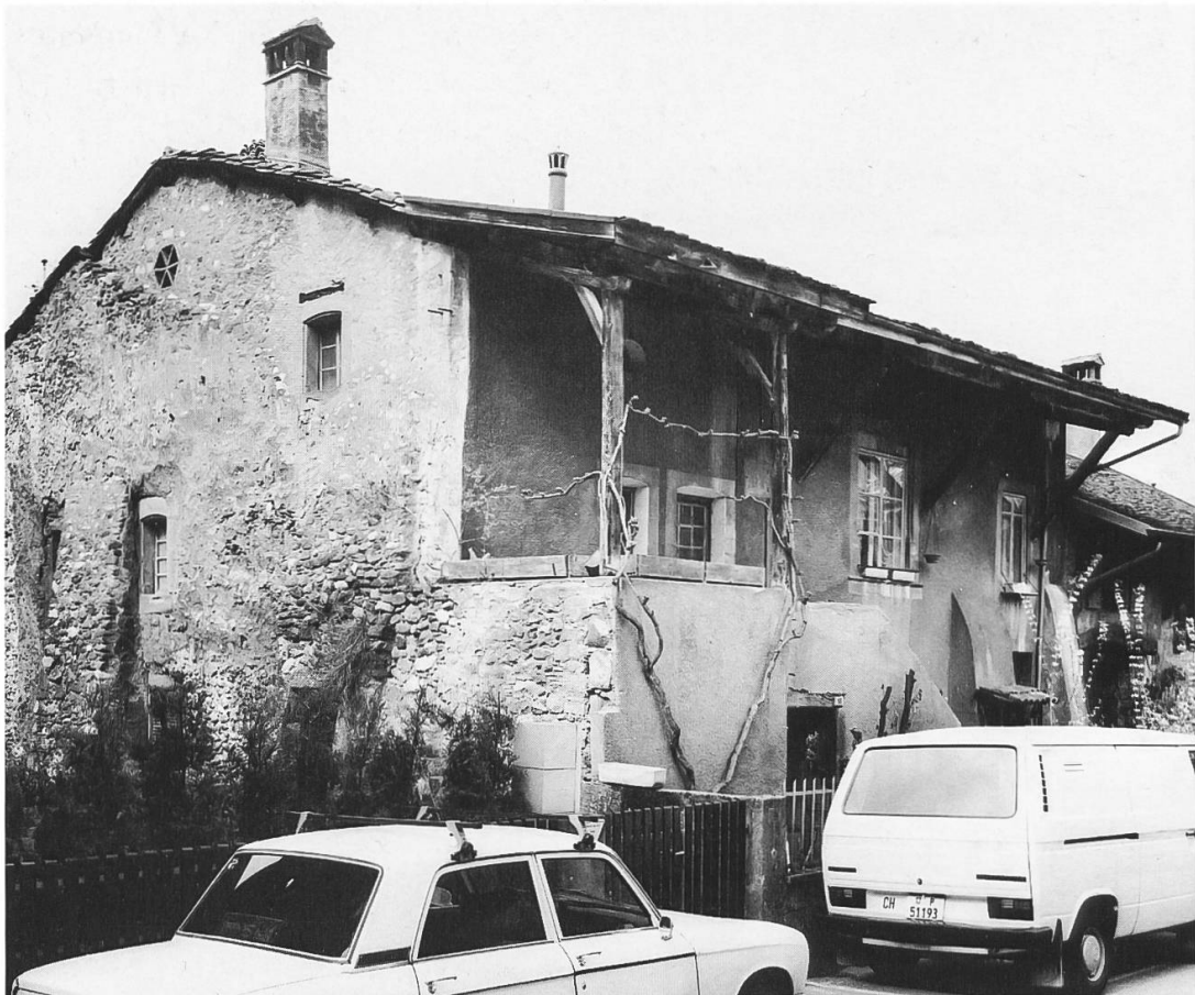
Fig. 27. Les n° 13 et 15 de la rue du Nord. L'immeuble n° 13, à gauche, remonte au XIII e -XIV e siècle et a été fortement transformé vers 1843; le n° 15 conserve une fenêtre, anciennement à meneau, du XVI e siècle.
