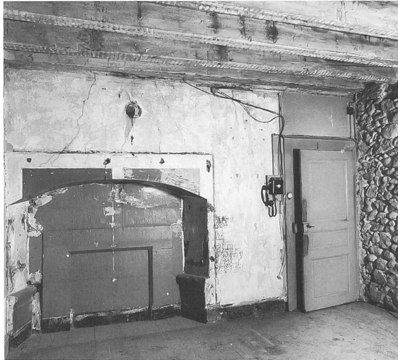
Fig. 43. «Chaudanne» placée au milieu du XVI e siècle derrière la cheminée de la figure précédente. Cette niche permettait de chauffer la pièce par la diffusion de la chaleur de la cheminée de la cuisine.
