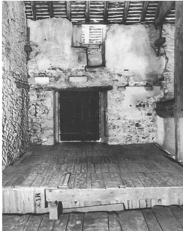
Fig. 49. Vestiges de l'annexe médiévale dans la façade sur rue de la grange des années 1800 au n° 3 de la rue du Midi. En haut: restes de la fenêtre du XV e siècle avec siège latéral.
