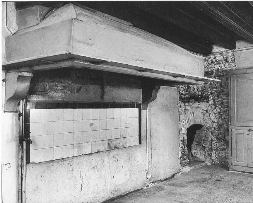
Fig. 42. La cuisine au premier étage de l'aile ajoutée au XIV e siècle au n° 35 de la rue du Midi et remaniée aux XVI e et XVII e siècles. Les solives du plafond datent de 1342-43 et la cheminée du XVIII e siècle, vraisemblablement.
