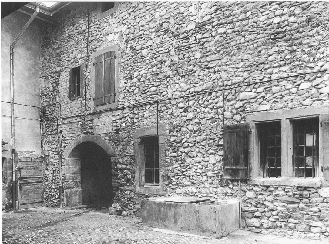
Fig. 44. Face orientale du n° 35 de la rue du Midi. La partie basse du mur constituait au XIII e siècle un mur de cour, surélevé lors de l'agrandissement du bâtiment vers 1343.
