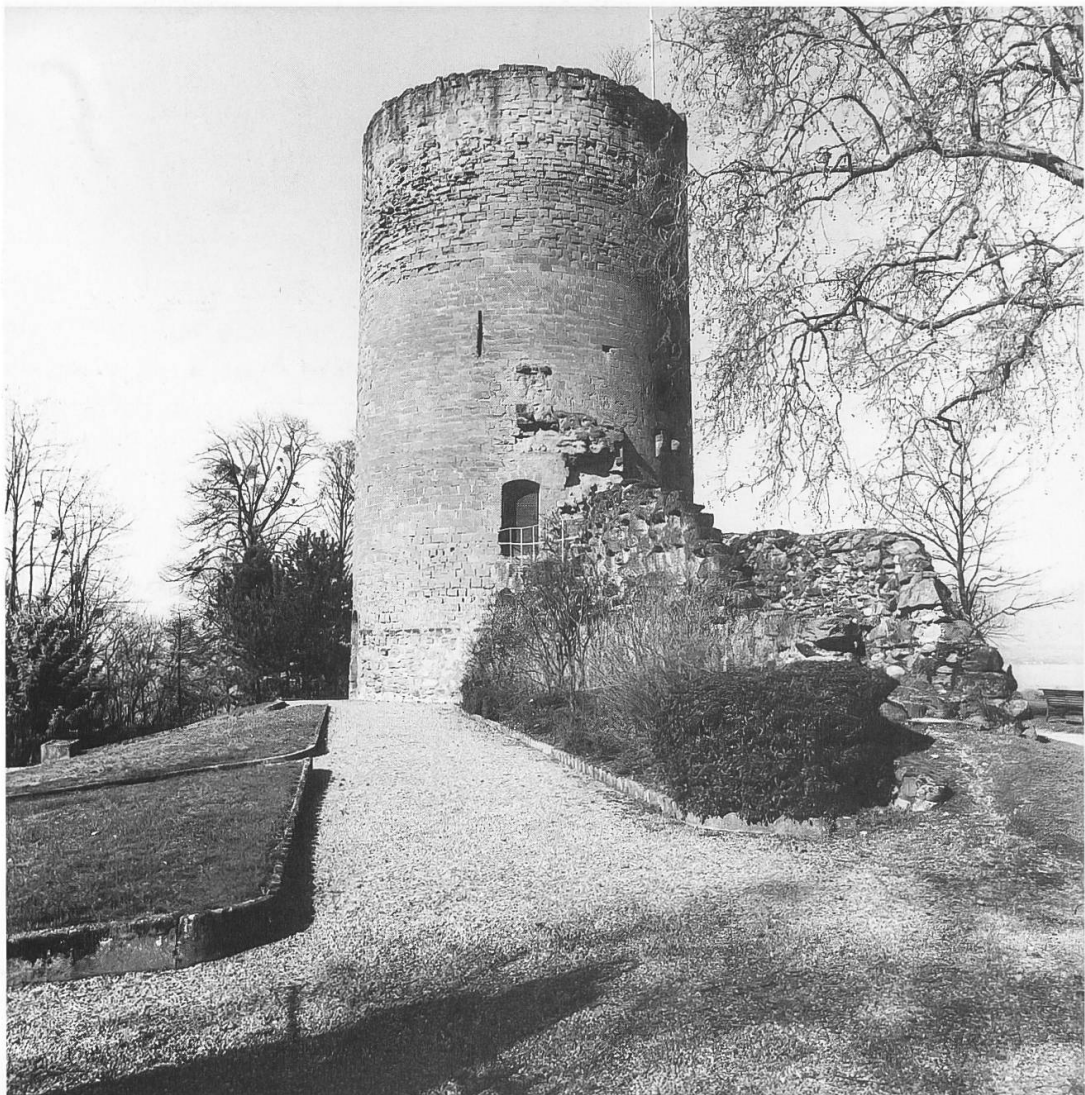
Fig. 3. Tour et vestiges de la courtine sud du château.
