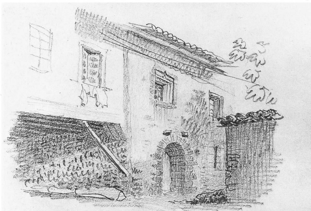
Fig. 61. Dessin de Paul Decrue représentant la façade côté lac du n° 15 de la ruelle des Galeries vers 1870, avec la porte cintrée et la fenêtre de la cave du XIII e -XIV e siècle (coll. CIG).
