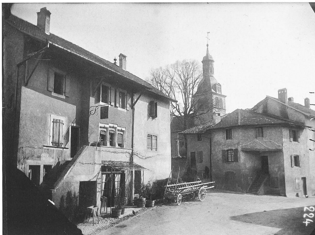
Fig. 64. L'ancienne auberge de la Couronne aux n° 544-546 de la route d'Hermance avant sa restauration (coll. CIG).
