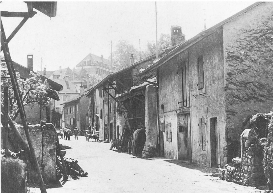
Fig. 31. La rue du Centre et ses maisons paysannes (coll. CIC).
