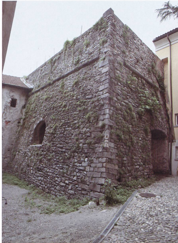
Saliente del «rivellino» del castello di Locarno (foto Garbani)
