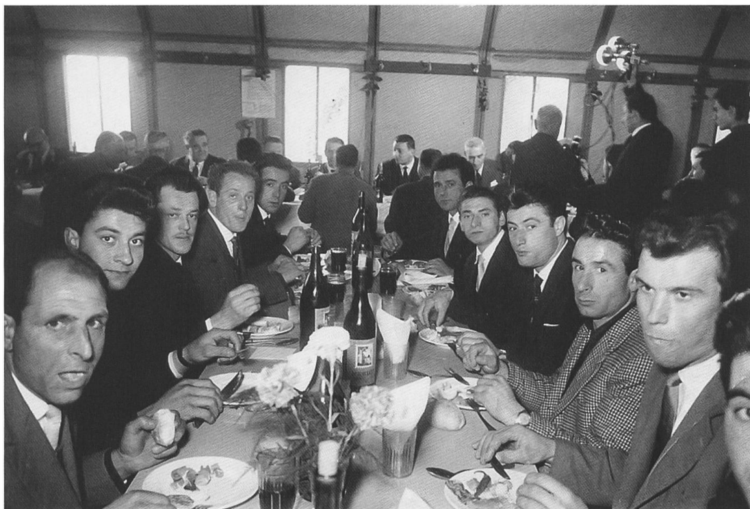
Festa di Santa Barbara sul cantiere della diga della Verzasca (4 dicembre 1963) (Archivio Privato)
