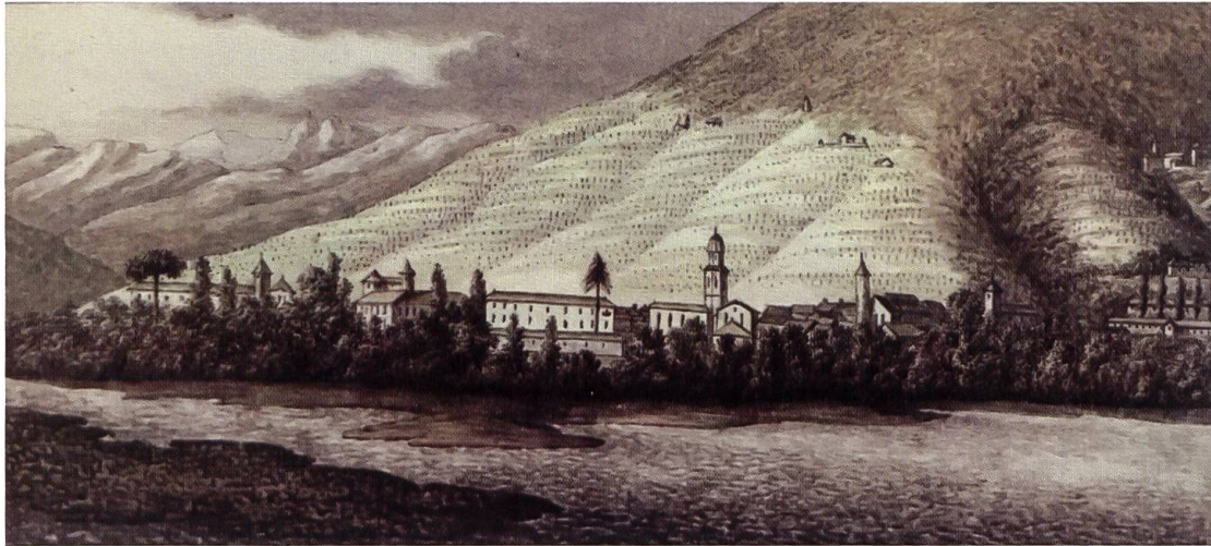
Ill. 9 Hans Conrad Escher von der Linth, Locarno am Ausfluss der Maggia (Locarno allo sbocco della Maggia), 1795. Zentralbibliothek, Zurich.
