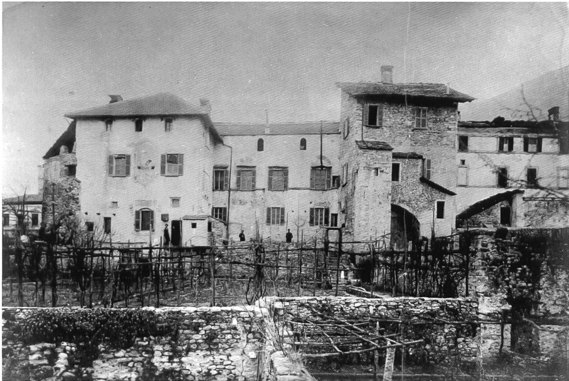
Facciata verso Piazza Castello: fotografia del 1868. Archivio della città di Locarno, Restauro del castello 1922-1926, fotografie.
