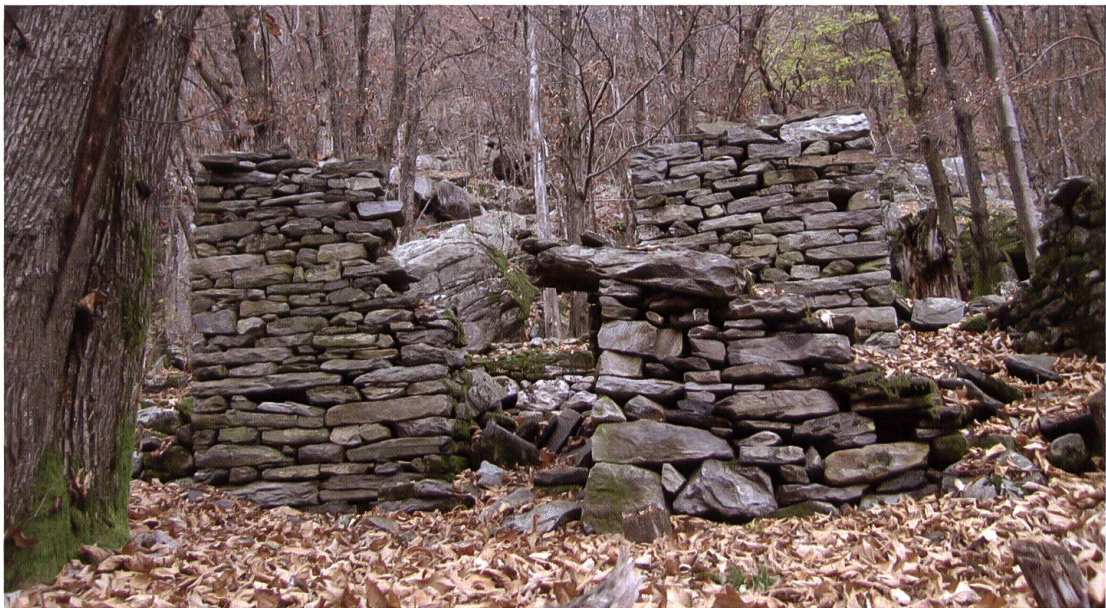
Fig. 7. Facciata di una stalla: si riconoscono la base della scala e la predella che davano accesso al piano rialzato, quello destinato al foraggio.
