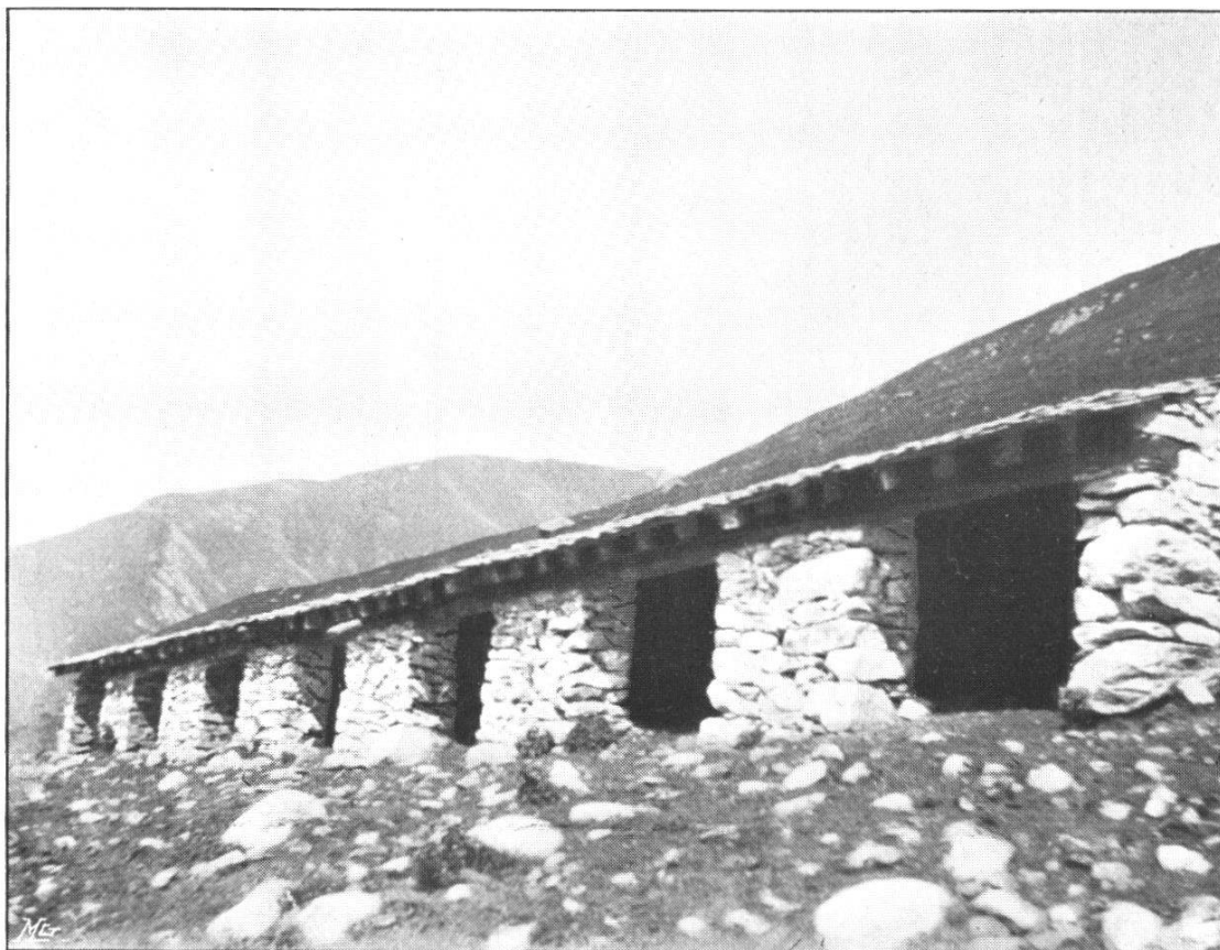
Abri à bétail sur l'Ulricher Galen.
