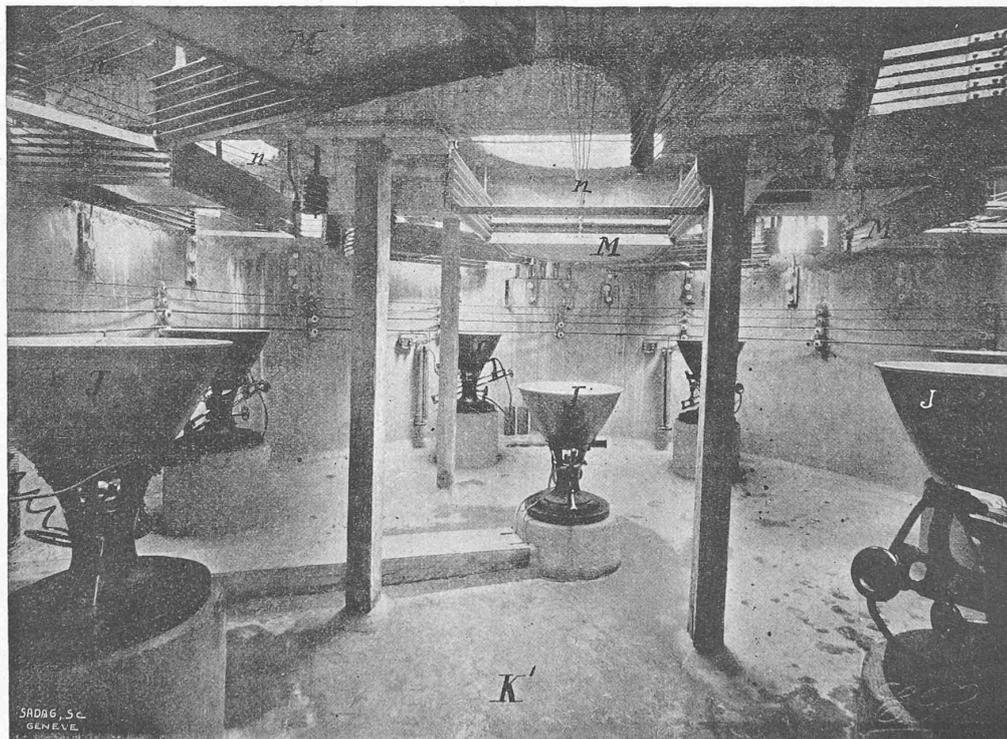
L'éclairage de la cascade est obtenu au moyen de 6 lampes H réglables à la main, consommant chacune 80 ampères. Ces brûleurs se composent essentiellement de deux porte-charbons, isolés l'un de l'autre et commandés ensemble par une vis à filets gauche et droit. Un réflecteur métallique h, en forme de gouttière, à axe horizontal, fait converger les rayons vers la
