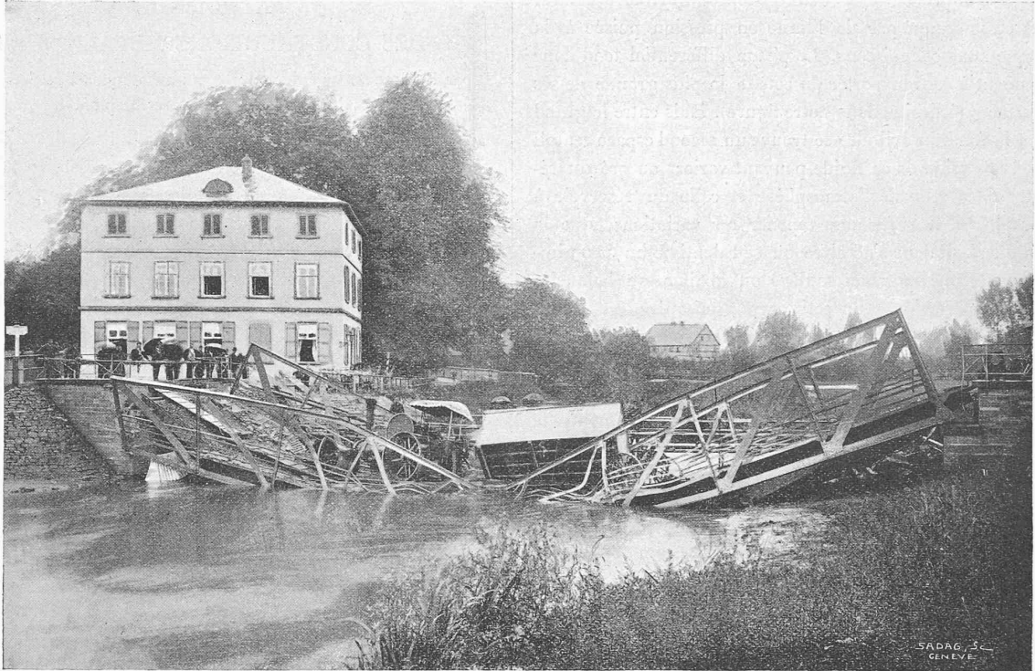
Fig. 1. — Pont sur la Niede, à Praunheim.
