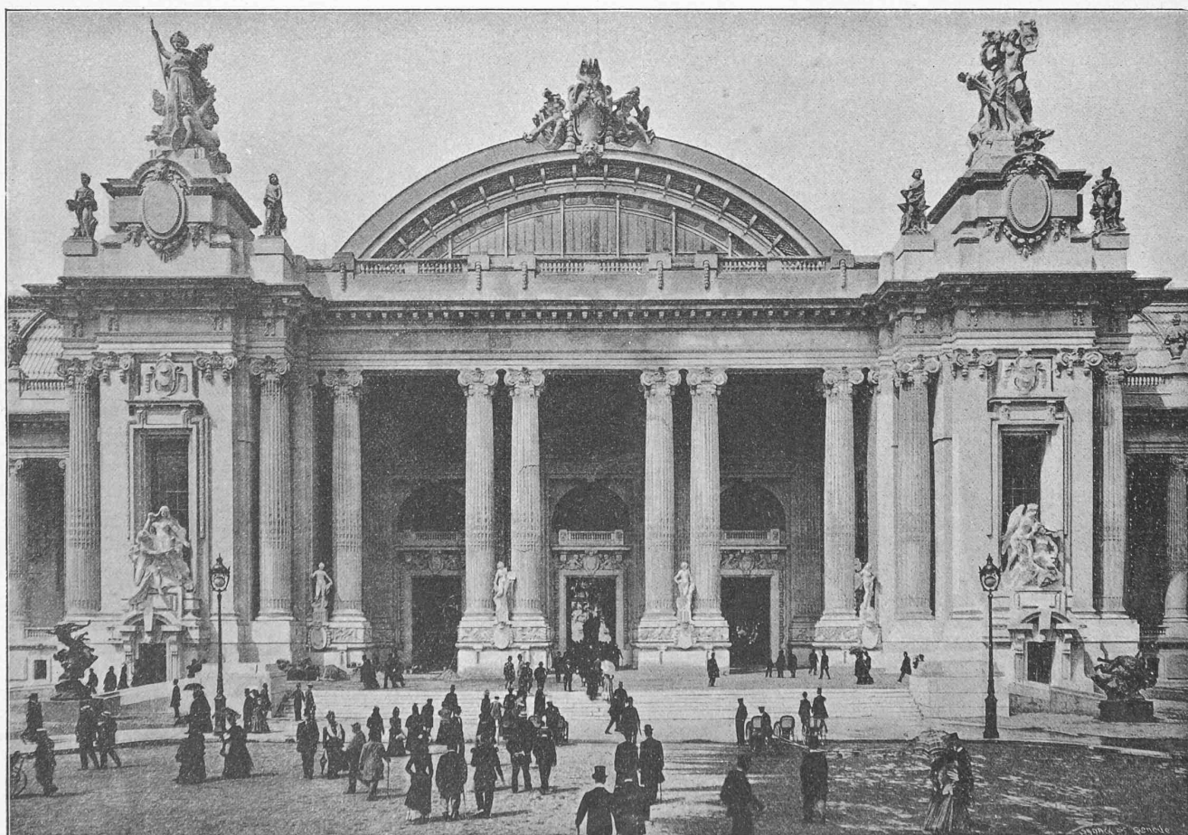
Fig. 2. — GRAND PALAIS (Entrée sur l'avenue Nicolas).
