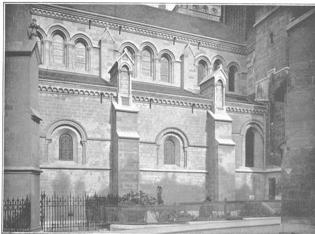
NEF ET BAS-COTÉ SUD APRÈS LES TRAVAUX DE RESTAURATION
