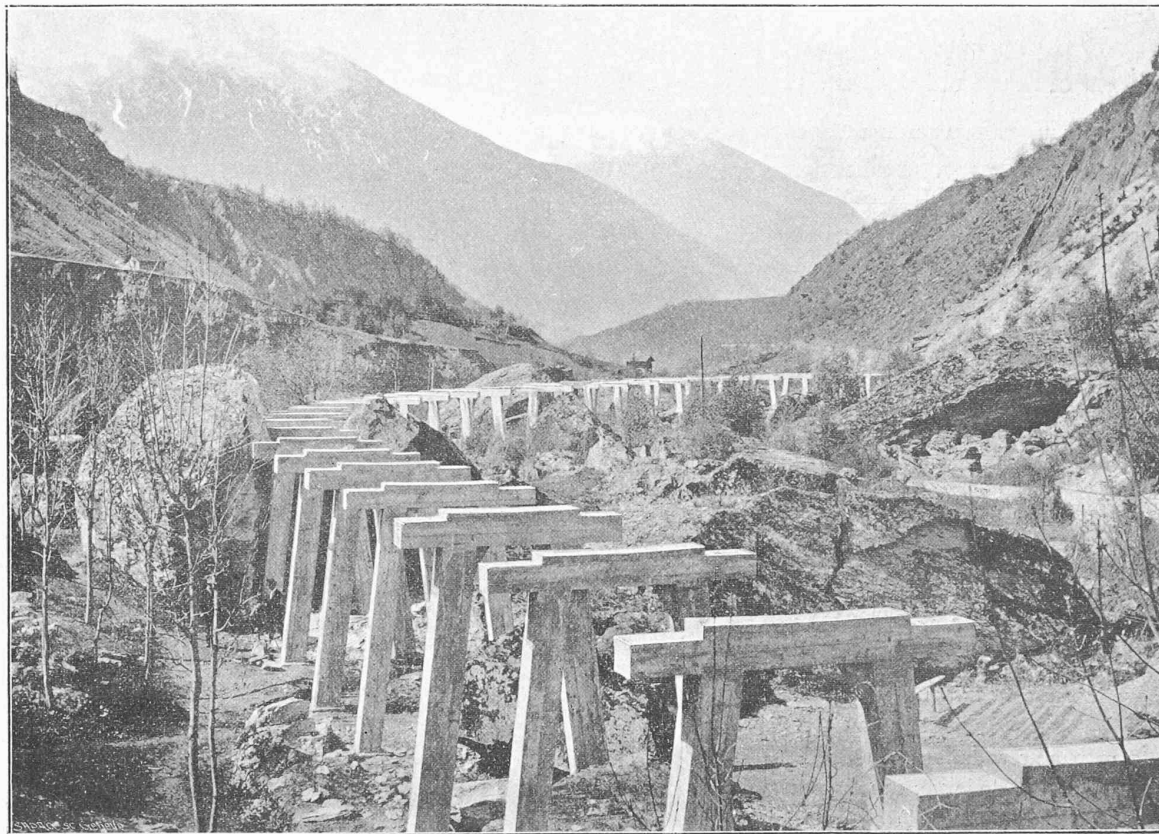
Fig. 2. — CONSTRUCTION DU CANAL EN CIMENT. (Chevalets en ciment armé destinés à supporter le canal).
