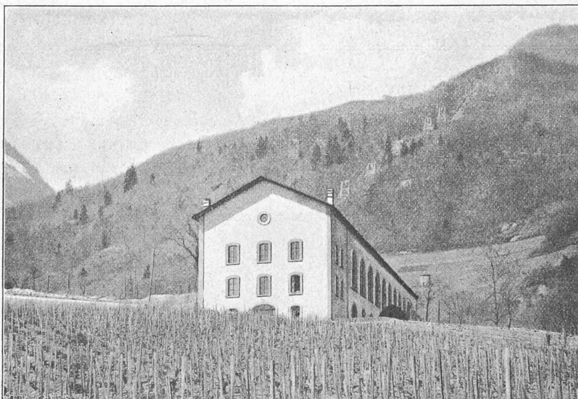
Fig. 2. — Vue générale de l'installation.
