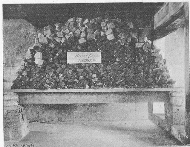
Fig. 2. — Essai de charge de la poutre N° 1.
