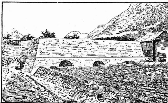
Cube: 1611 m<sup>3</sup> de béton, 557 m<sup>3</sup> de maçonnerie en chaux hydraulique de Vallorbe *seconde qualité*. Les tuyaux de prise de charge ont 2<sup>m</sup>,75 de diamètre.
