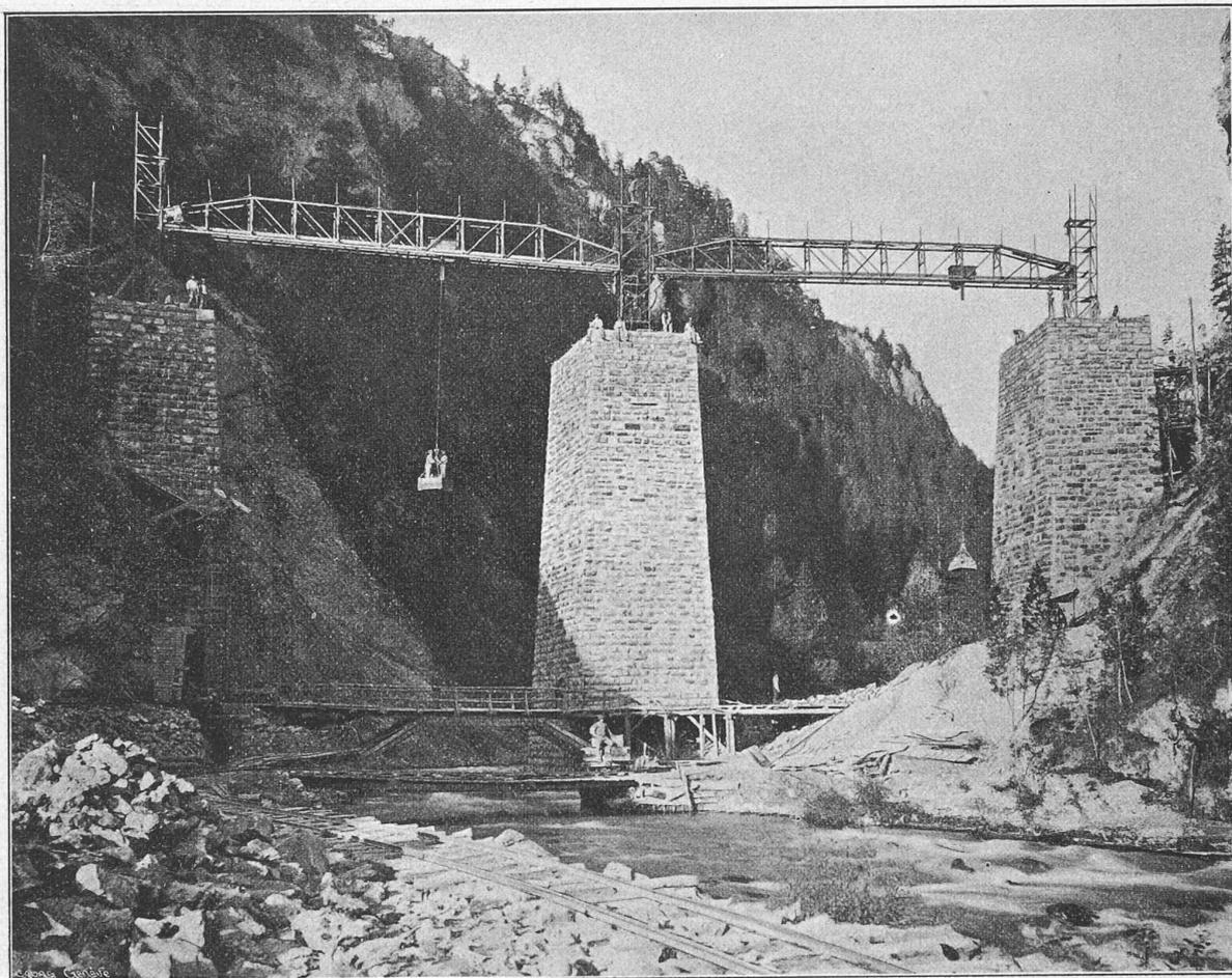
Fig. 12. — Montage des piles du viaduc du Landwasser.
