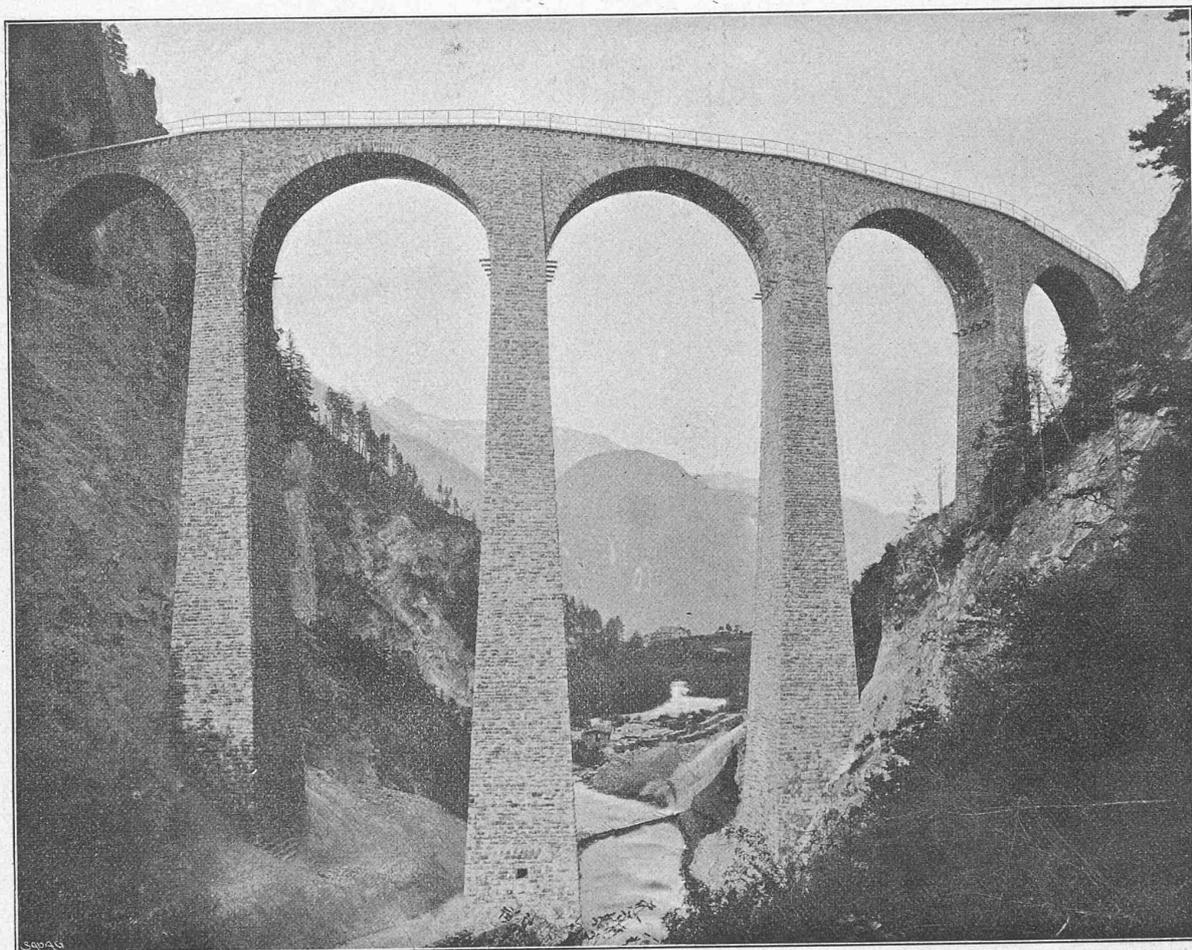
Fig. 11. — Viaduc du Landwasser. — Hauteur 65 m. Ouverture des arches 20 m.
