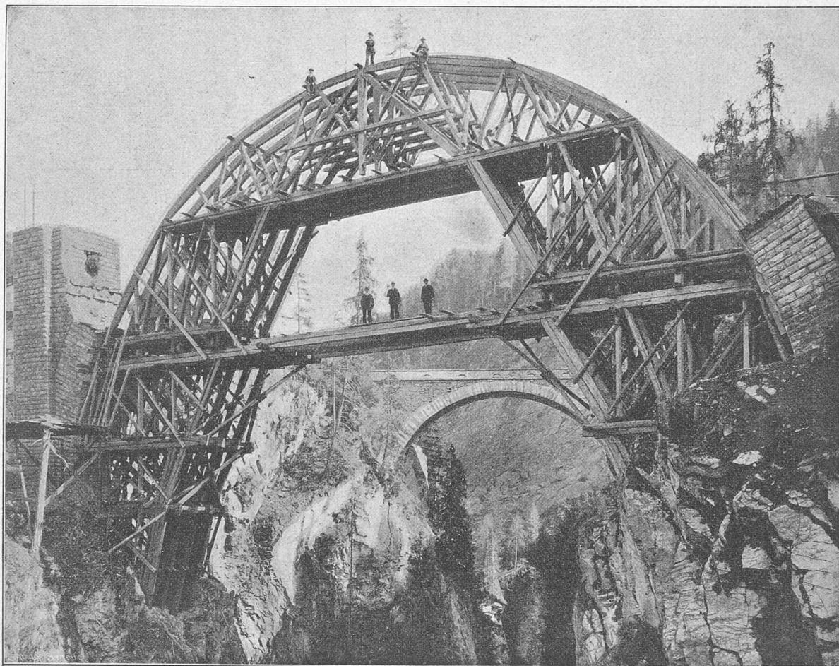
Fig. 10. — Cintre de l'arche centrale du viaduc de Solis. — Ouverture 42 m.
