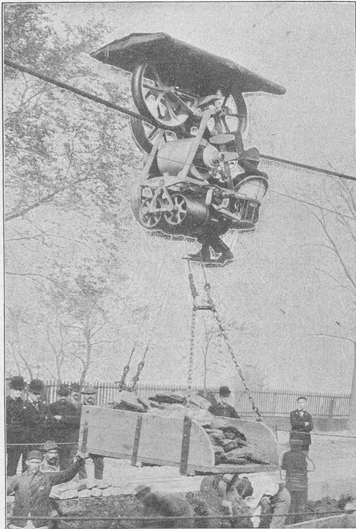
Fig. 8. — Blondin électrique. Détail du chariot.
