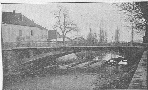
Fig. 1. — Pont de Jallieu (Isère).
