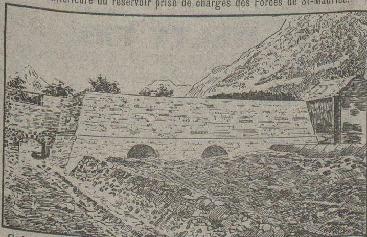
Cube: 1611 m<sup>3</sup> de béton, 557 m<sup>3</sup> de maçonnerie en chaux hydraulique de Vallorbe seconde qualité. Les tuyaux de prise de charge ont 2m,75 de diamètre.
