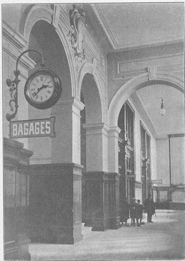
Fig. 7. — Vestibule au niveau de l'avenue des Alpes.
