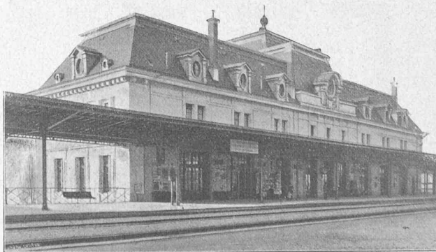
Fig. 10. — Façade côté voies.
