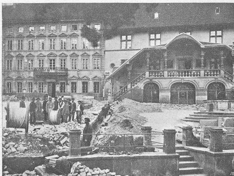
Fig. 10. — Pose des câbles devant l'Hôtel cantonal.
