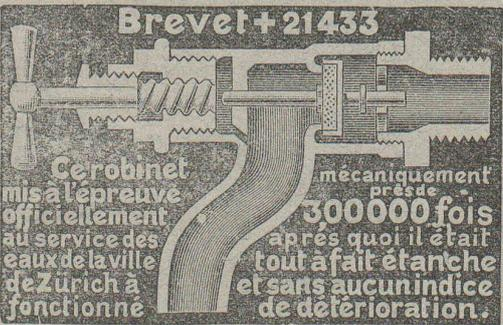
Cerobinet mis à l'épreuve officiellement au service des eaux de la ville de Zurich à fonctionne
