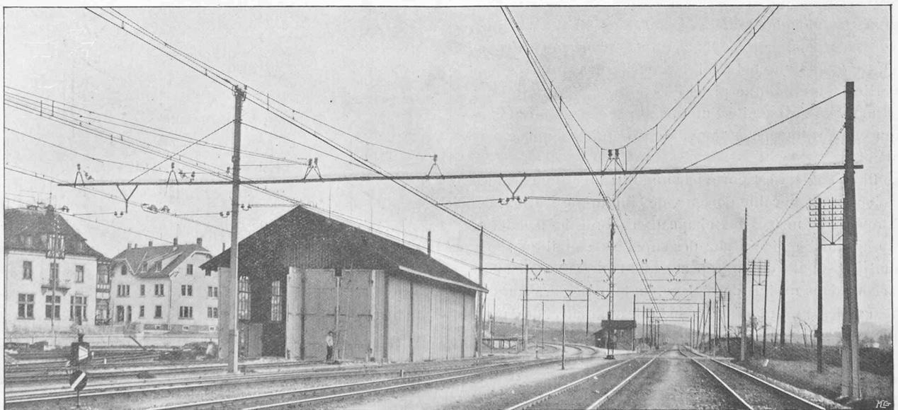
Fig. 24. — Station de Wettingen. Pont-support pour 6 lignes à suspension caténaire.
