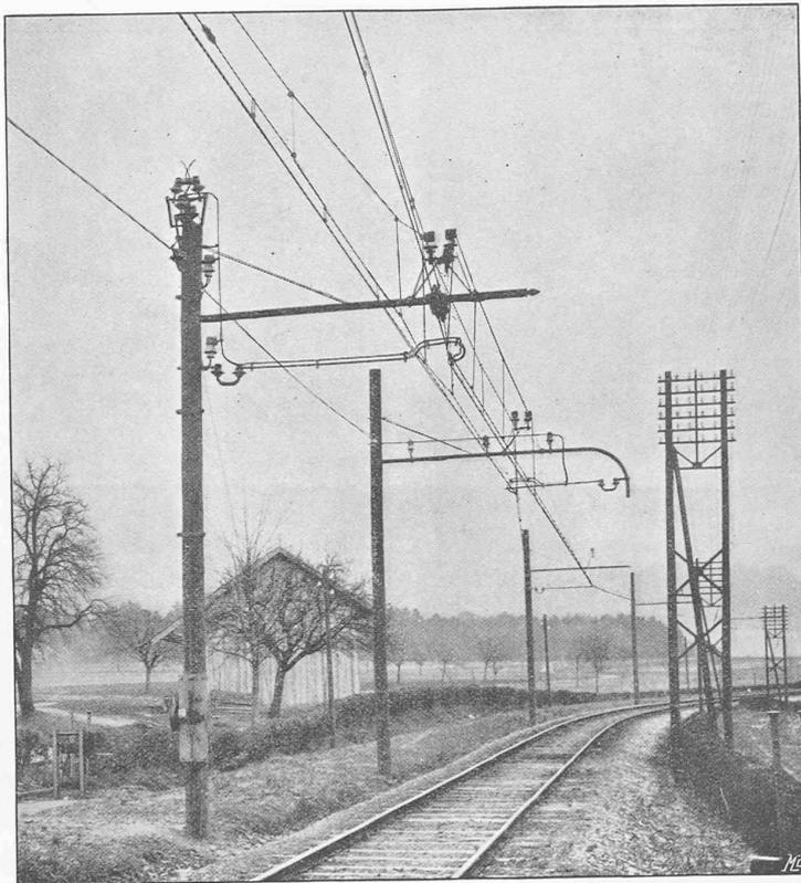
Fig. 25. — Interrupteur de section. — Passage à niveau.
