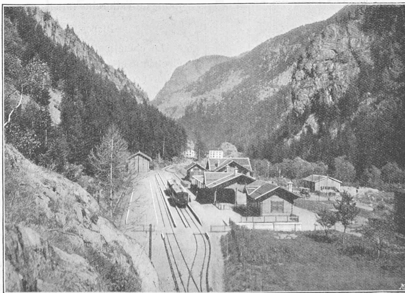
Fig. 4. — Vue de la gare du Châtelard.
