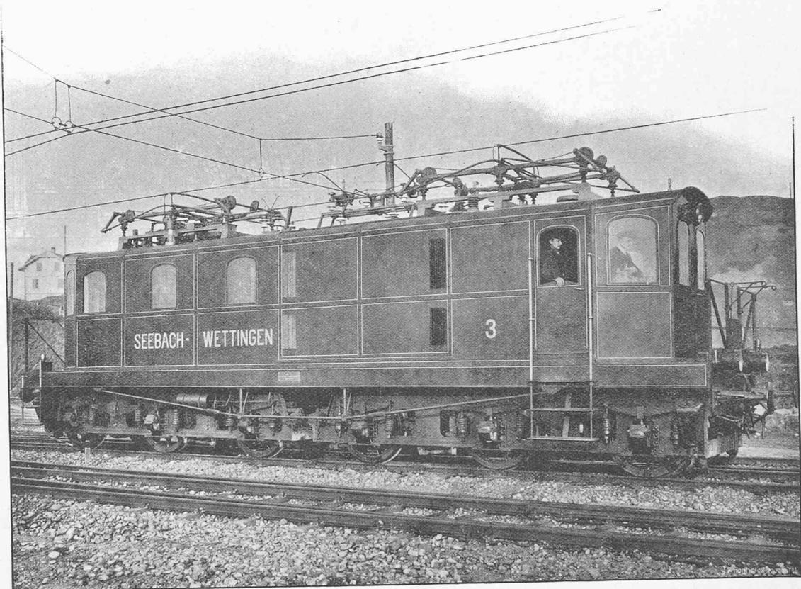
Fig. 40. — Locomotive de 1000-1500 HP à 6 essieux moteurs.
