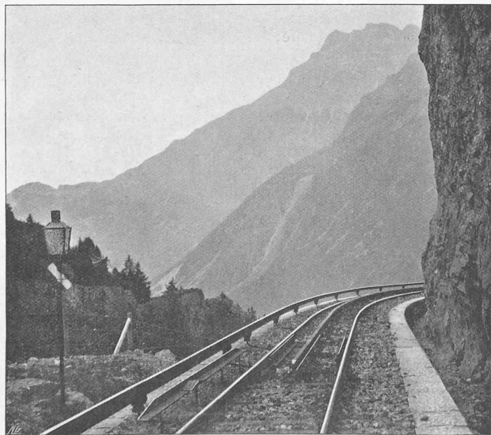
Fig. 32. — Extrémité supérieure du tronçon à crémaillère.
