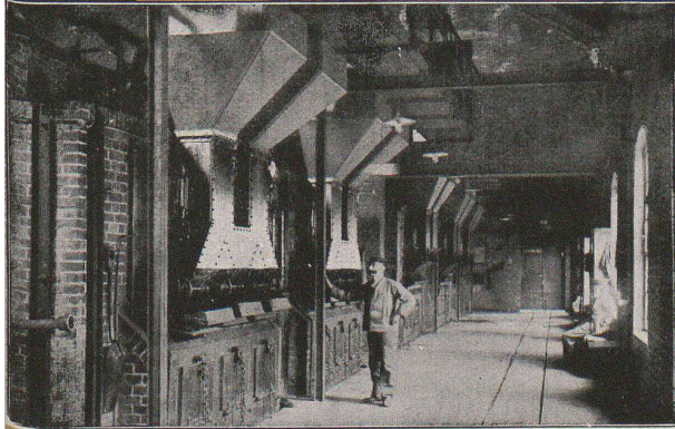
Installation d'alimentation automatique de générateurs
