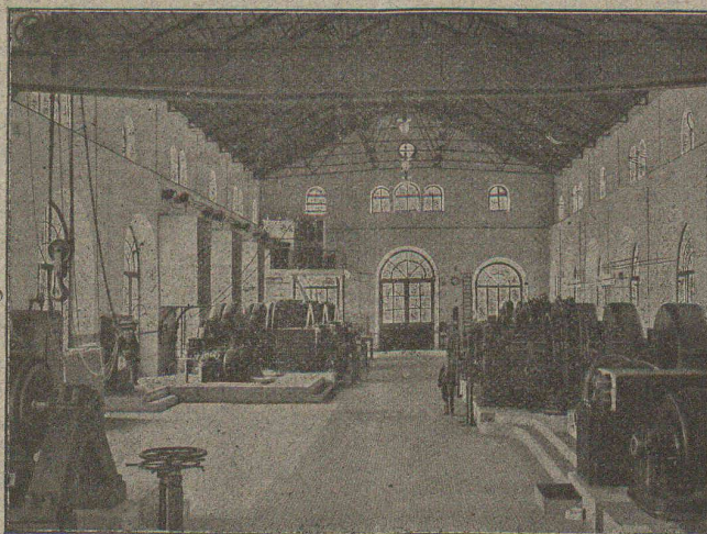
Usine d'électrochimie de Martigny. — Local des turbines.
