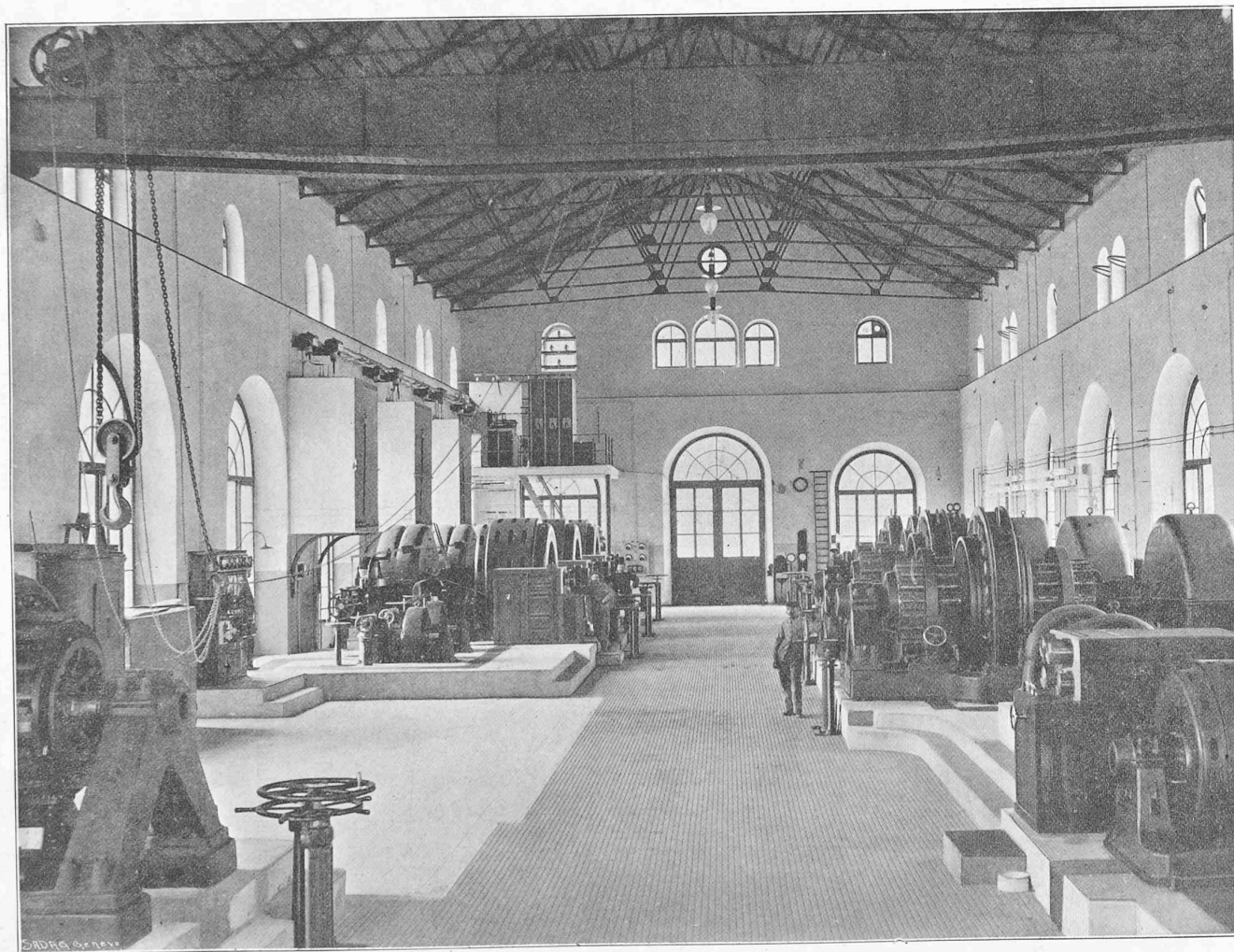
Fig. 18. — Salle des machines. — Vue générale prise de l'aval.
