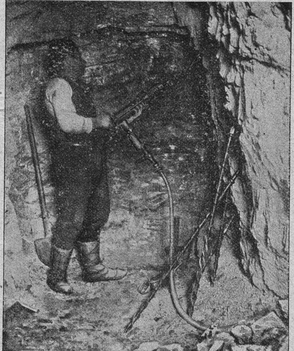
Marteaux perforateurs à air comprimé.
