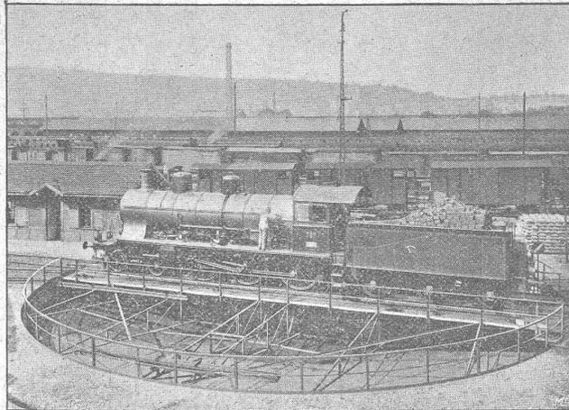
Pont tournant électrique de 20 m., gare Zurich.
