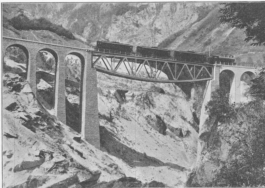
Fig. 4. — Viaduc de Betschieder : 5 arches en maçonnerie de 8 m. ; travée métallique de 50 m. construite par la maison Wartmann, Vallette & C ie .
