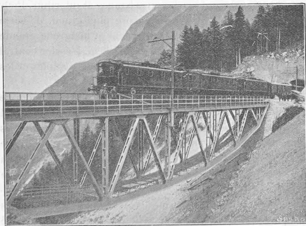
Fig. 9. — Pont du Sarengraben, de 70 m. de portée, construit par les Ateliers mécaniques de Vevey.
