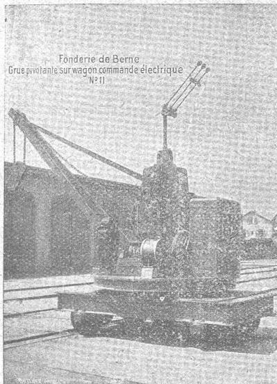
**Appareils de levage** : Ponts roulants, Grues pivotantes ou fixes et sur chariots. Commande à bras ou électrique. Monte-charges hydrauliques, électriques ou à courroie.
