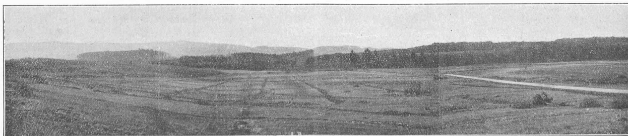
Fig. 13. — 2 me section pendant l'exécution des travaux.
