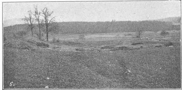
Fig. 15. — 2 me section pendant l'exécution des travaux.
